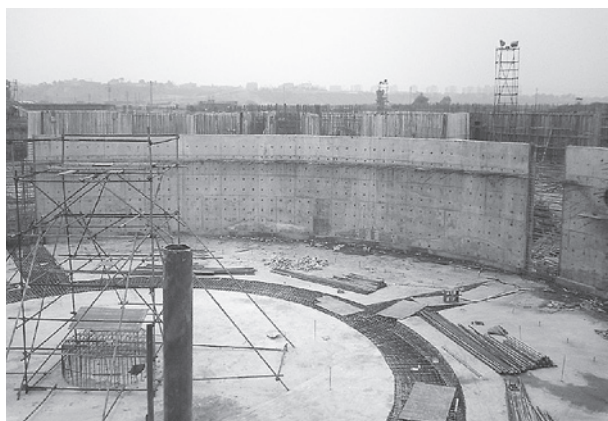
建設中の汚水処理場 重機はほとんど見えない(陝西省西安市)
